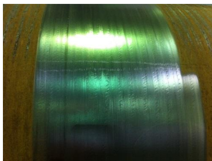
Рис. 5 Удаление сплошной коррозии с помощью корд-щетки
